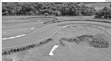
Obras começaram na semana passada
